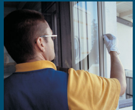
Huonokuntoiset tiivisteet on vaihdettu.
