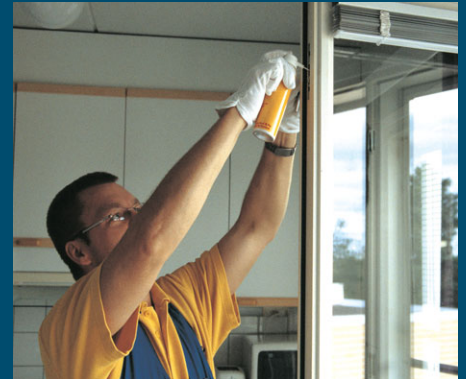
Lukot on voideltu ja säädetty.
