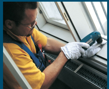
Puiteliut ovat ehjät.
